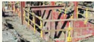
El sistema de postes para barandilla de Pro-Tec Equipment funciona como una medida preventiva adicional, y ofrece la posibilidad de instalar una barandilla temporal alrededor de las excavaciones que usan entibados y cajas para zanjas.
