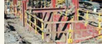
El sistema de postes para barandilla de Pro-Tec Equipment funciona como una medida preventiva adicional, y ofrece la posibilidad de instalar una barandilla temporal alrededor de las excavaciones que usan entibados y cajas para zanjas.
